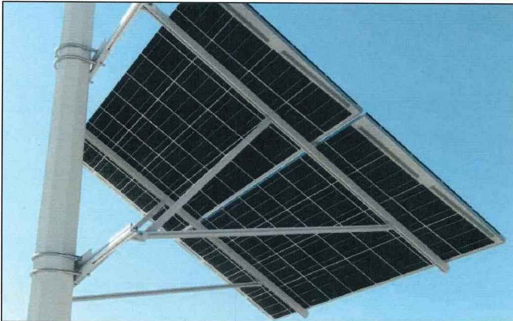
Ilustración. Montaje de Clamps Ejemplo
