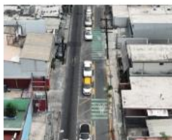
◀ Izq. Previo a mantenimiento a la infraestructura ciclista de calle Pedro Martínez. Der. Después de mantenimiento a la infraestructura ciclista de calle Pedro Martínez. Fuente: SEDUSO
