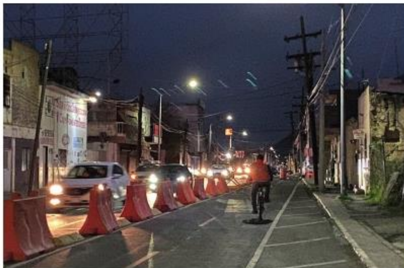
> Trabajos de mantenimiento en ciclovia Pedro Martínez. Fuente: SEDUSO
