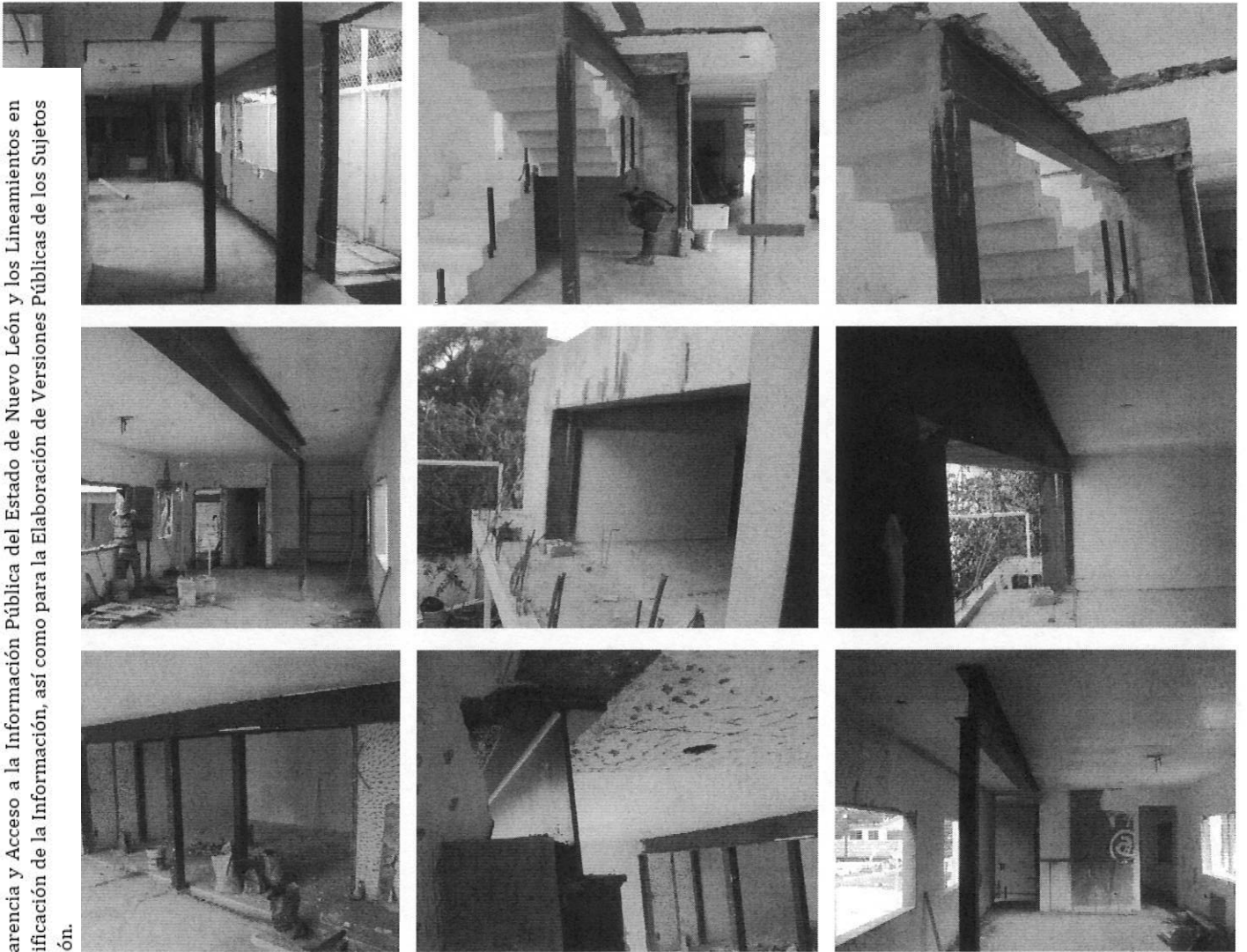
VISTA DE LOS TRABAJOS DE REMODELACION Y COLOCACION DE VIGAS DE ACERO AL INTERIOR DE LA EDIFICACION
