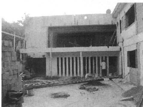
VISTA DE AREA LIBRE CENTRAL AL INTERIOR DEL PREDIO
