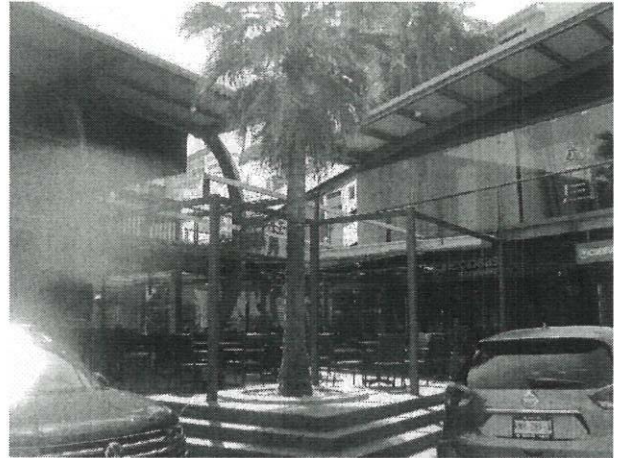
ESTRUCTURA METALICA PARA TECHAR AREA COMUN
