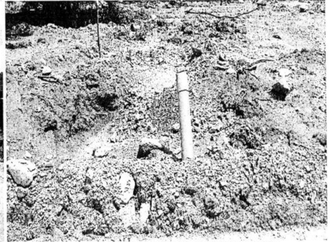
ACOMETIDA DE DRENAJE SANITARIO
